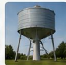
nádrž na vodu
